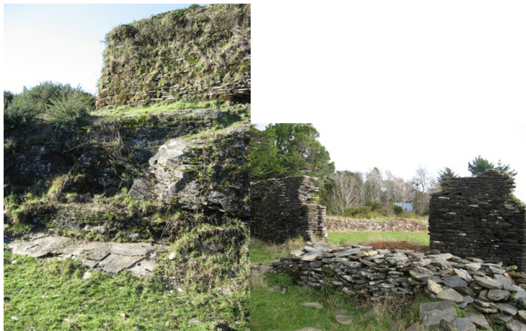
Figuras 4a y 4b. Imágenes del Fuerte de Amargos (izquierda) en cuya construcción y posteriores restauraciones se utilizó la cancagua y el esquisto (nótese el afloramiento metamórfico en la base del muro) y el Castillo de Mancera, en cuya construcción y posteriores restauraciones también se utilizó la cancagua y el esquisto.
